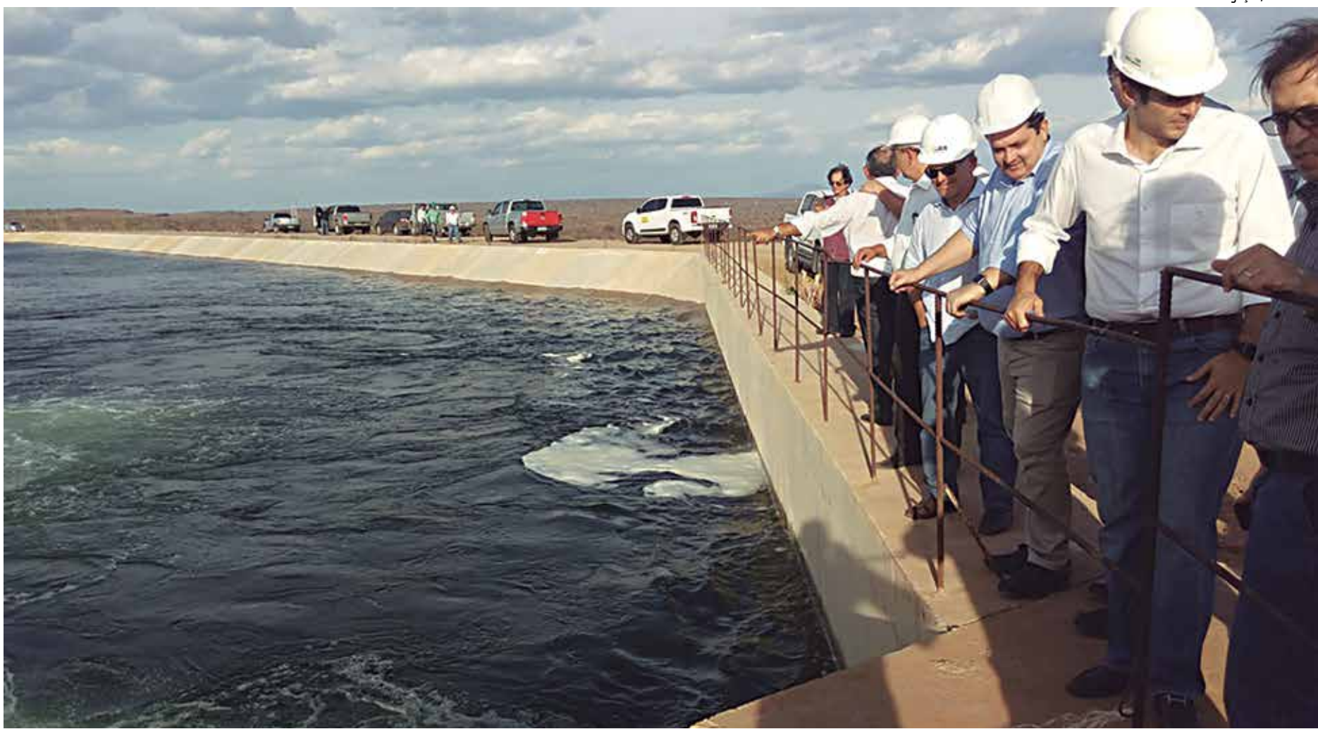
Águas do Rio São Francisco serão despejadas no leito do Paraíba e abastecerão os açudes São José, Poções e Camalaú, antes de chegar ao açude Boqueirão
